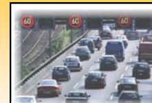
Geschwindigkeits- beeinflussung / Fahrstreifen- steuerung
